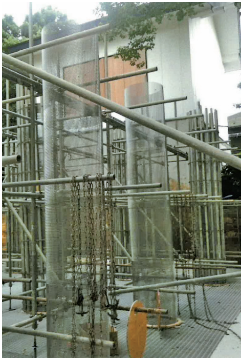
図-5 メッシュ殻（ステンレス）組み立て作業
